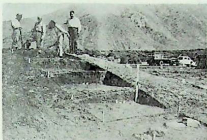
Escalonamiento de una excavación
